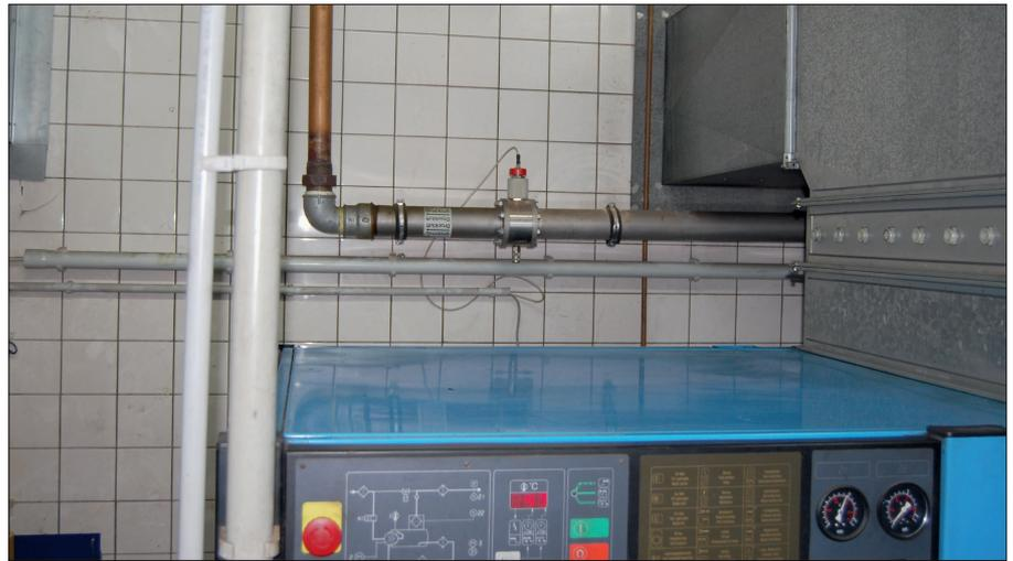
kommt modernste Messtechnik zum Einsatz: Mit der Baureihe „complete 201“ verfügt Postberg über ein eigenes Sensor-Programm, das genauen Aufschluss über die Druckluftströme im Netz des Anwenders gibt und somit – entsprechendes Know-how bei der Auswertung vorausgesetzt – eine gute Grundlage für die Planung von Optimierungsmaßnahmen bietet. ■
