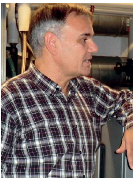
■ Abb. 2: Thomas Meibert, Energiemanager der Firma Hübner in Kassel, erläuterte den Seminarteilnehmern bei deren Besuch in der KWK-Druckluft+ Anlage die getroffenen Maßnahmen und deren Einsparungen in der Praxis. © LVT
