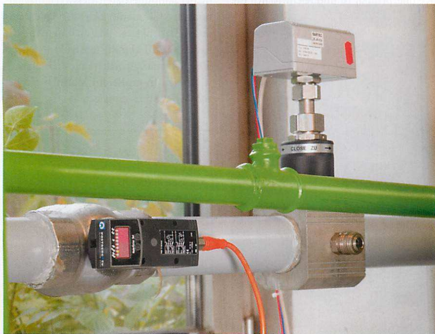
Eine vom Controlling-Dienstleister installierte leistungsfähige Messsensorik erfasst die Druckluft-Kenngrößen permanent und deckt Schwachstellen im System auf
