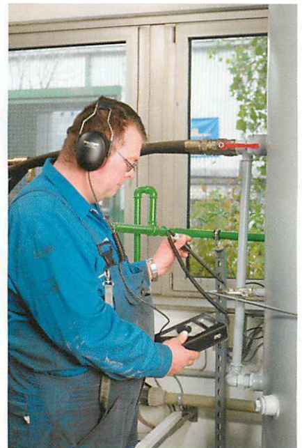
Die Leckagesuche gehört ebenfalls zum Leistungsspektrum eines Spezialisten für Druckluftcontrolling
